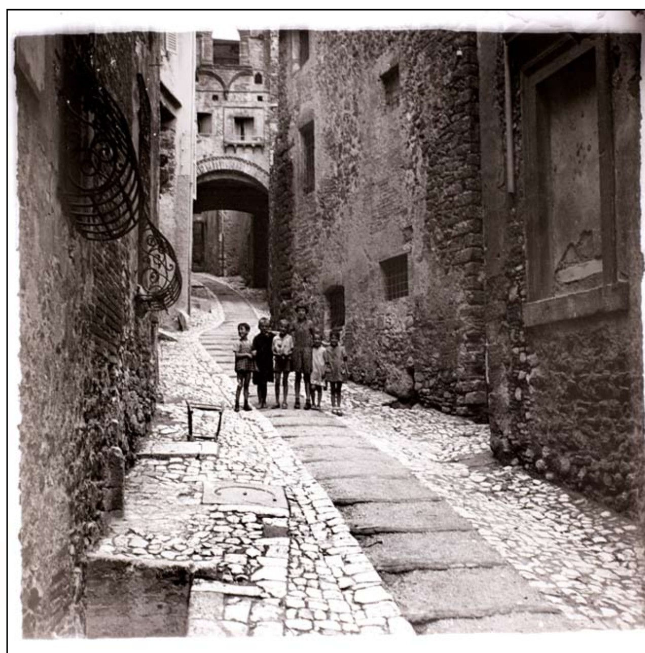
ARCO DI MANCINELLI
